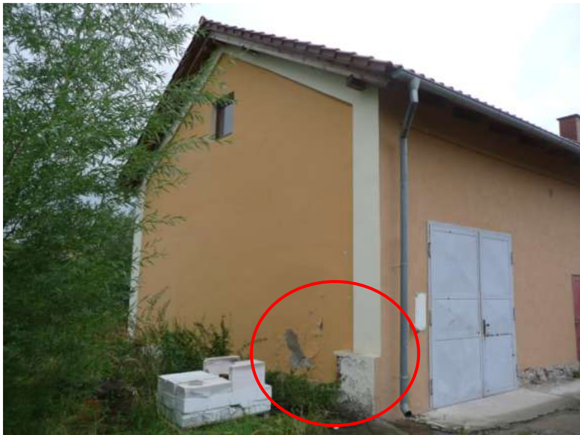
Nesoudržná, opadaná omítka na nároží západní a jižní fasády objektu
