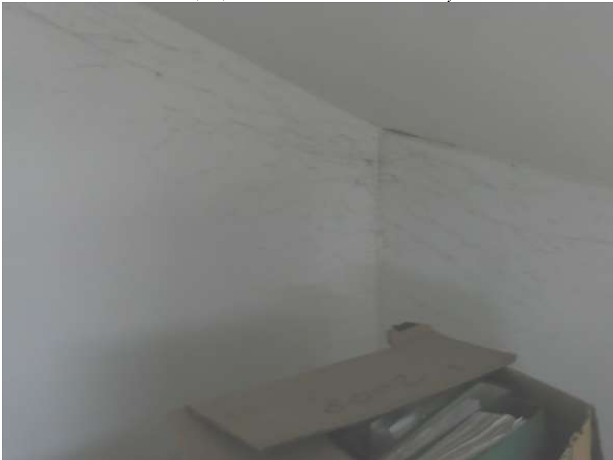
Pozice 5 – vlasová trhlina š.0,2-0,4 mm na fabionu šikmého sádrokarton. podhledu
