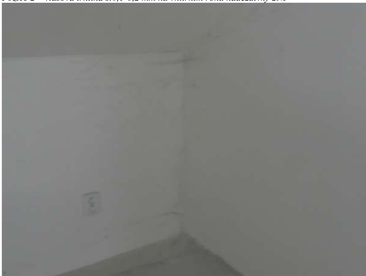
Pozice 2 – vlasová trhlina š.0,1-0,2 mm na vnitřním rohu nadezdívky 2NP
