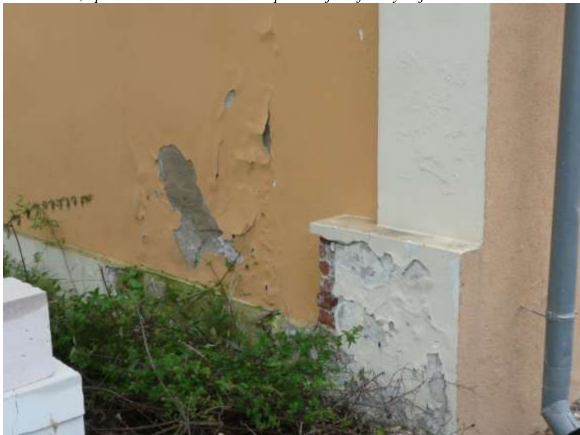
Nesoudržná, opadaná omítka na nároží západní a jižní fasády objektu
