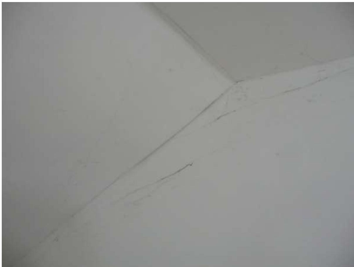
Pozice 2 – vlasová trhlina š.0,1-0,2 mm na vnitřním rohu nadezdívky 2NP
