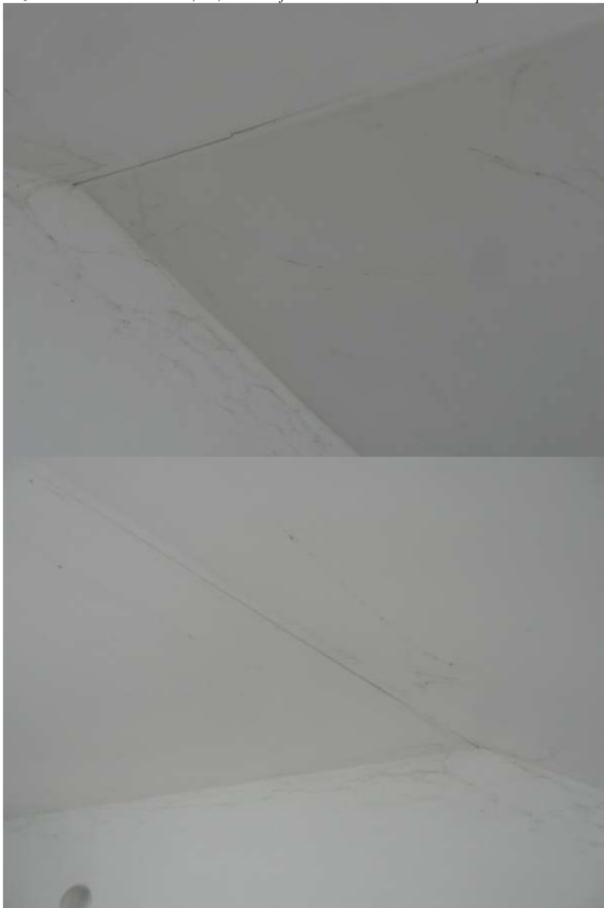
Pozice 3 – vlasová trhlina š.0,1-0,2 mm na fabionu šikmého sádrokarton. podhledu
