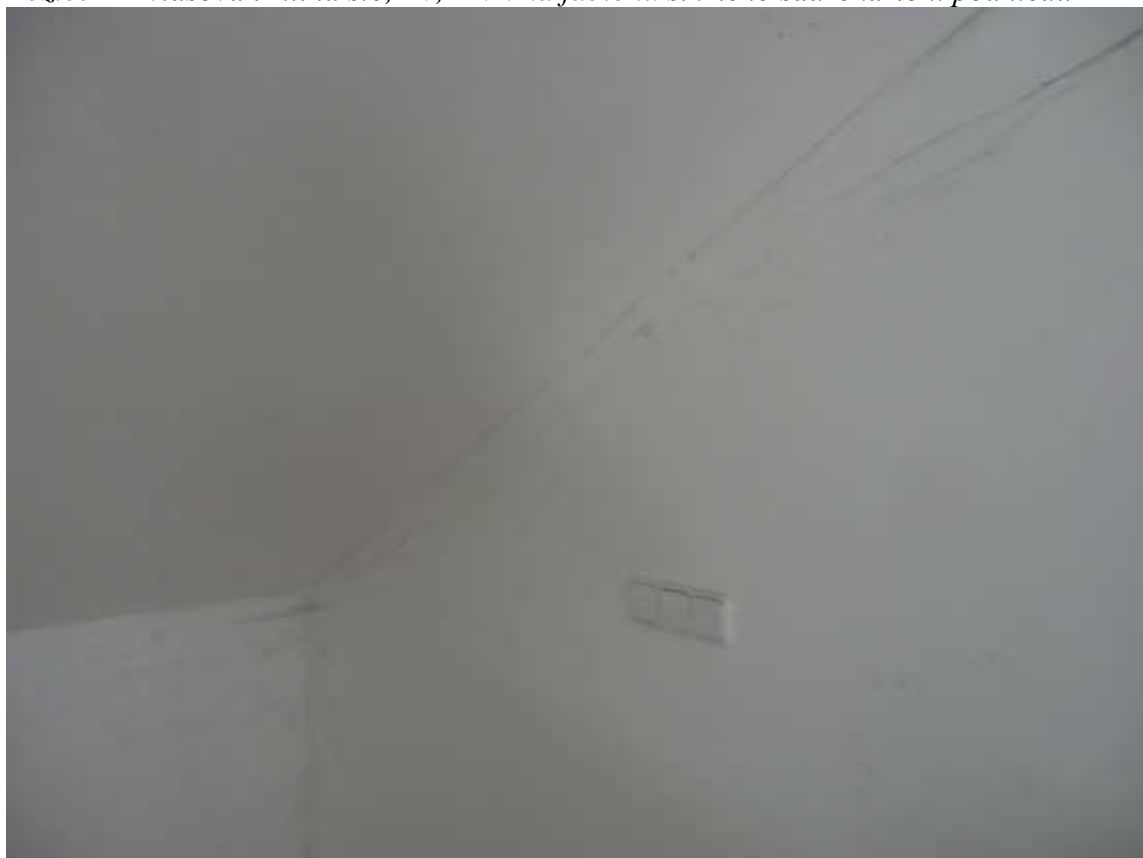
Pozice 1 – vlasová trhлина š.0,1-0,2 mm na fabionu šikmého sádrokarton. pohledu
