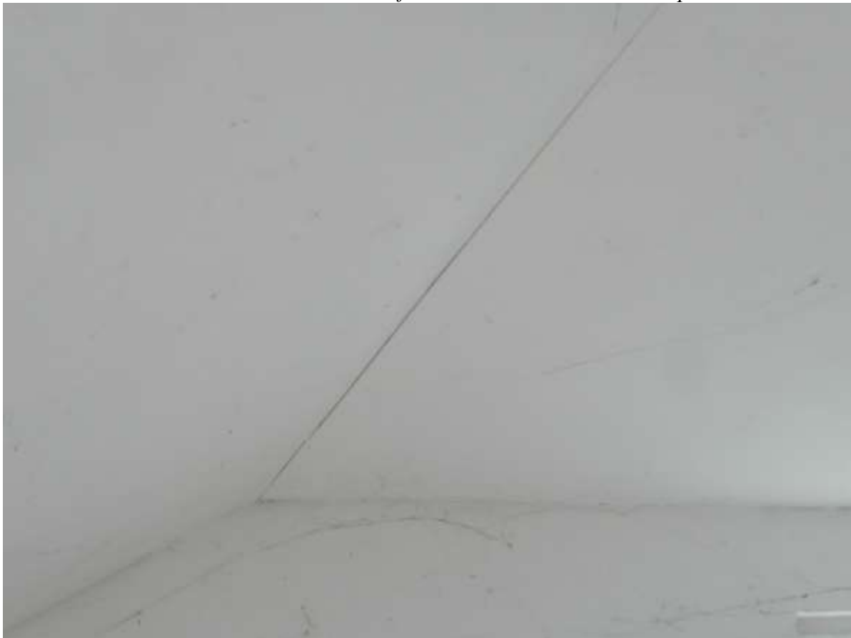
Pozice 5 – vlasová trhlina š.0,2-0,4 mm na fabionu šikmého sádrokarton. podhledu
